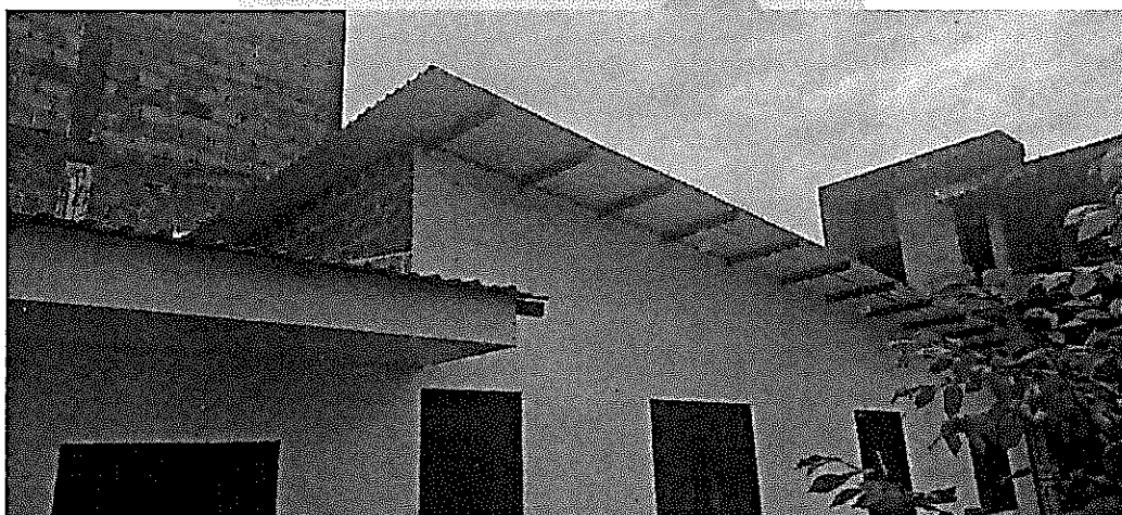
Foto 8. Cubierta liviana (perfil metálico + teja trapezoidal). Al fondo, estructura aporticada vecina de mayor altura (2-3 pisos), sin terminar.
