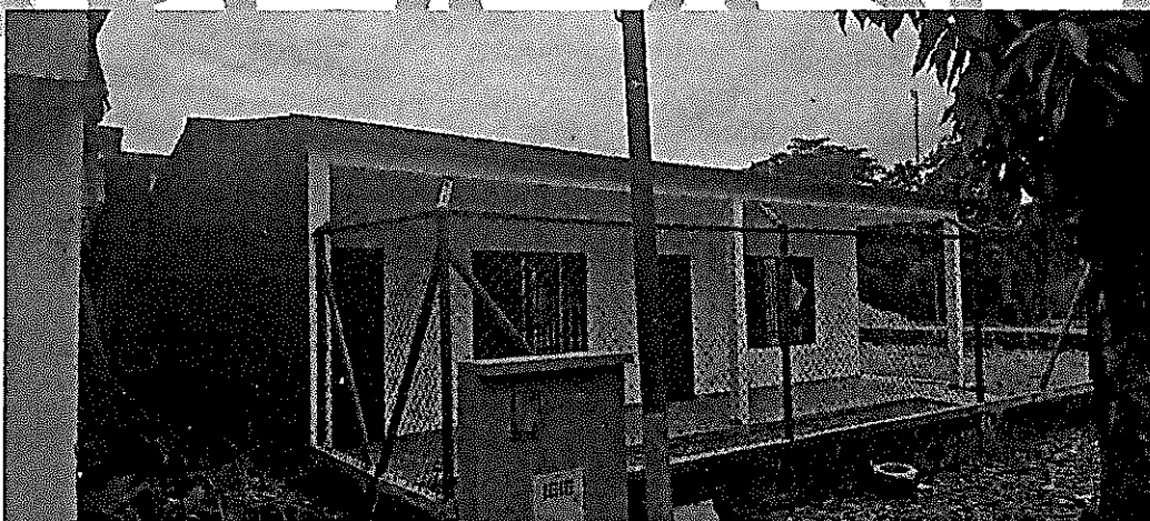
Foto 9. Costado con caja de medidor N.º 8805; muro de cerramiento y colindancia con edificación existente.
